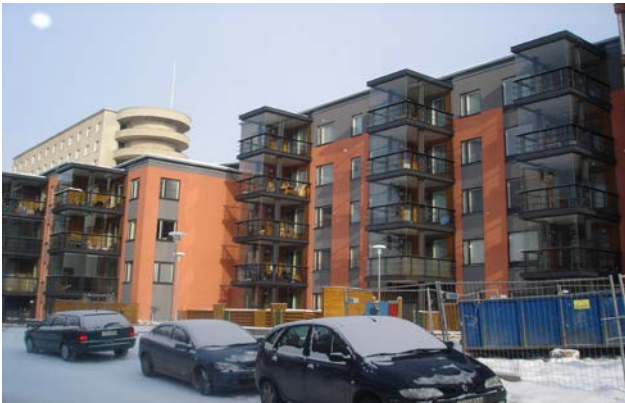
Kohteessa yhdistetty eristetyt elementit ja paikalla eristetvt sisäkuoret.
