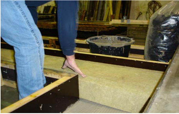
Eristeen asennus muottiin elementtitehtaalla.
