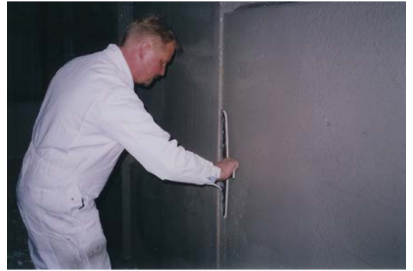
Laasti levitetään tasaiseksi esim. 60 cm leveällä tasoituslastalla. Sementtipohjainen suojalaasti voidaan levittää myös muottiin ennen eristeiden asennusta. Laastina tällöin Armatop MP Factory. Ilman suojalaastia eristepinnasta pitää harjata/hioa heikko pinta pois.
