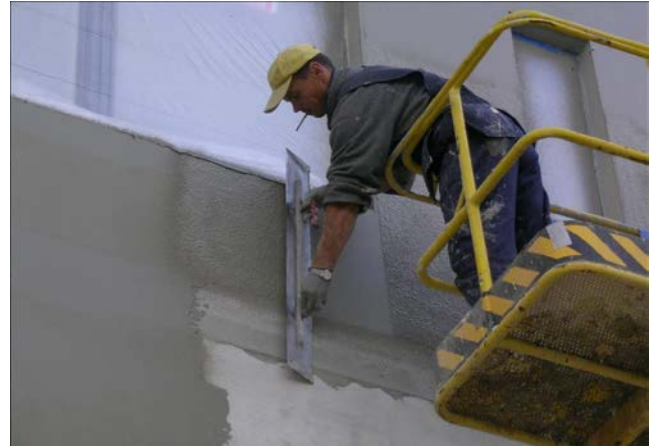
Limutusta pohjarappauksen päälle.
