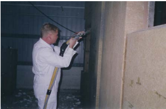
alsecco PreWisl 1 kivillaeristeen pinta suojataan UV-säteilyltä ruiskuttamalla eristeen pintaan suojalaastikerros, Armatop MP. EPS eristettä ei tarvitse erikseen suojalimuttaa.
